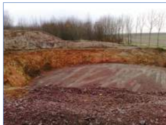
Figure 384 : Réalisation des terrassements pour les fondations d'une éolienne
