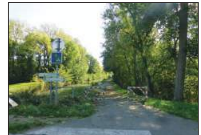
Figure 277 : Vélovoie le long de l'ancien canal de la Haute Seine
