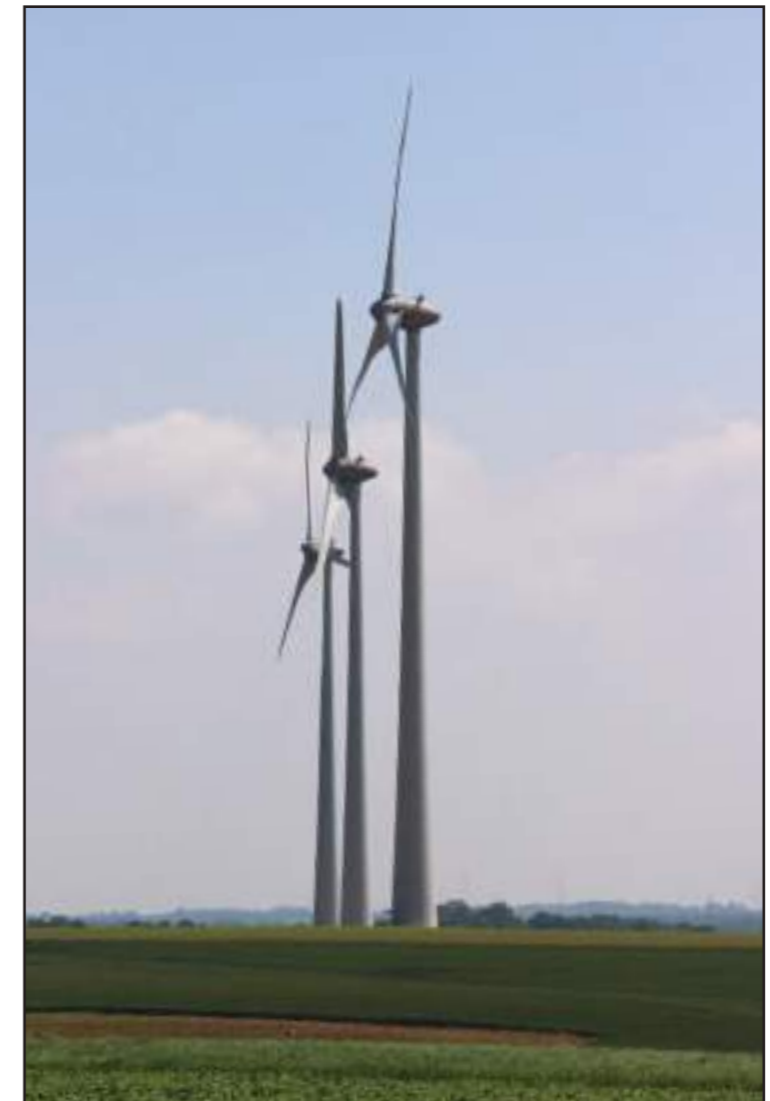
Figure 8 : Parc éolien du Mont d'Ergny (9 éoliennes de 2,3 MW), construit en 2012
