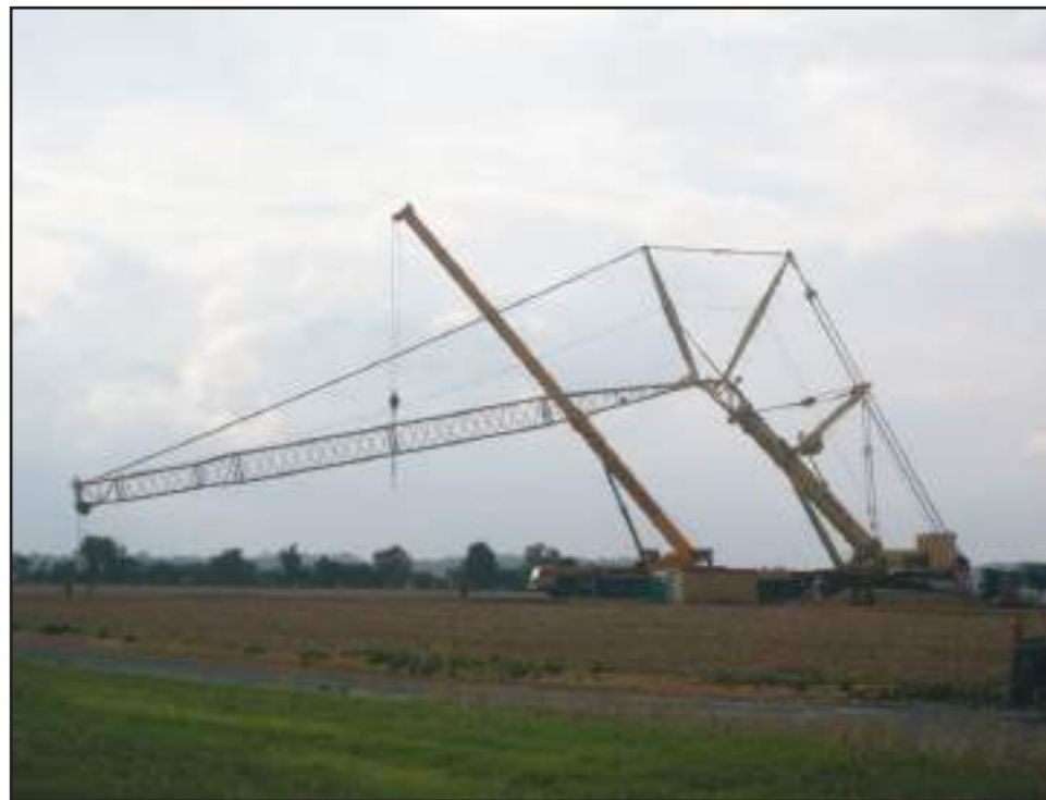
Figure 48 : Grue de levage à flèche en treillis
