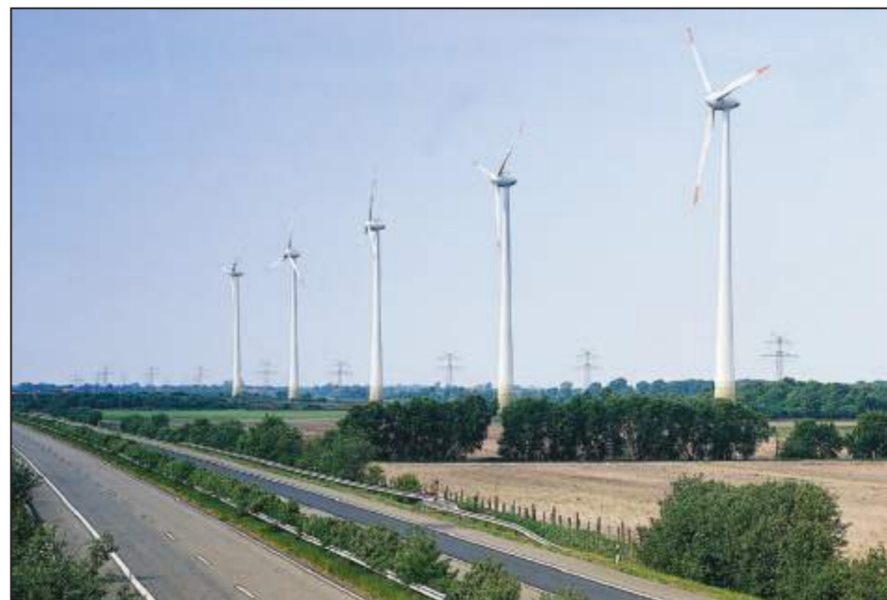
Figure 16 : Le parc éolien de Borsum (ENERCON E70, hauteur totale 133 mètres), réalisé par le groupe DGE
