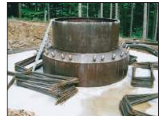
Figure 45 : Noyau de la fondation
