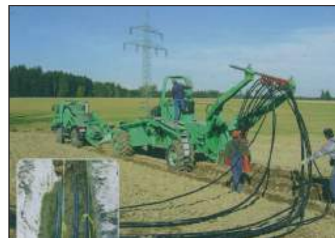
Figure 53 : Machine d'enfouissement de câbles
