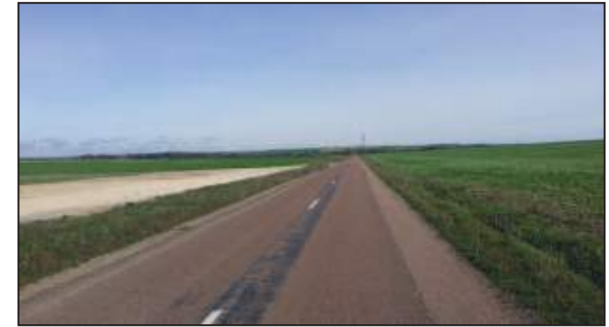
Figure 39 : Route départementale n°165
