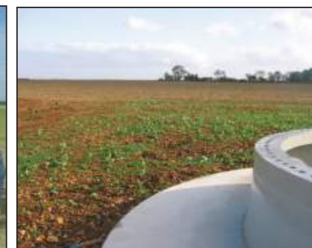
Figure 54 : Bord de la fondation recouvert de terre végétale et cultivable
