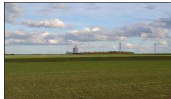
Figure 305 : Silo agricole au Nord-Est du bourg des Grandes Chapelles
