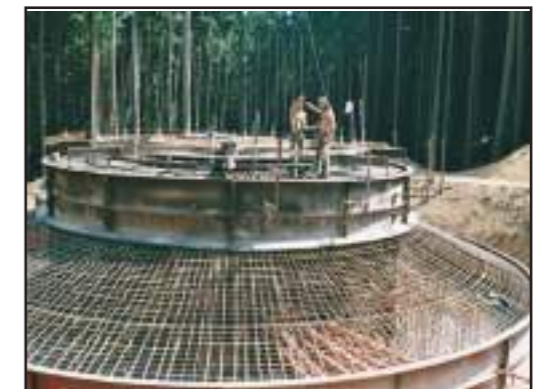
Figure 46 : Installation du coffrage
