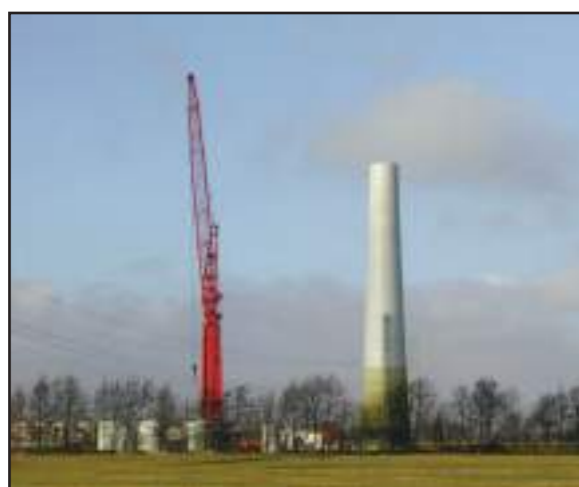
Figure 50 : Montage des tours
