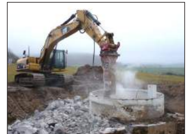
Figure 59 : Destruction du socle
