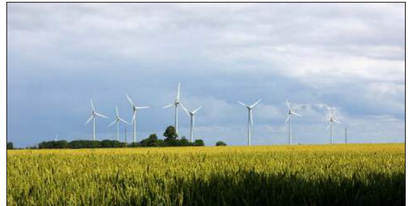
Figure 6 : Parc éolien de Garcelles-Secqueville (16 MW), construit en 2008
