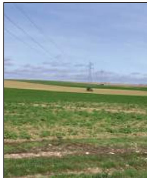
Figure 270 : La ligne à 63 000 volts Arcis-sur-Aube - Creney n°2
