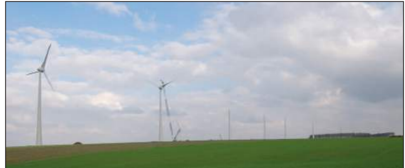
Figure 10 : Travaux du projet « Le Nouvion », parc de 24 éoliennes
