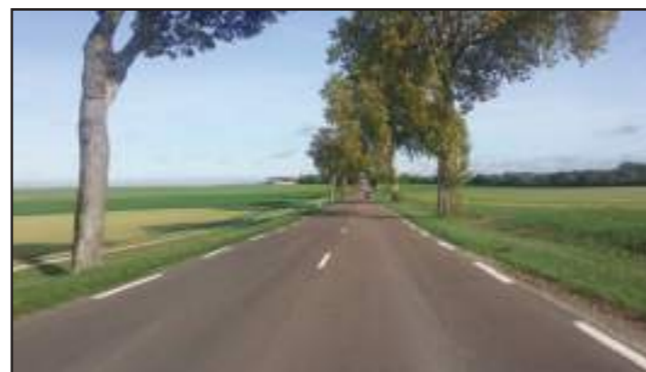
Figure 304 : Route départementale n°677
