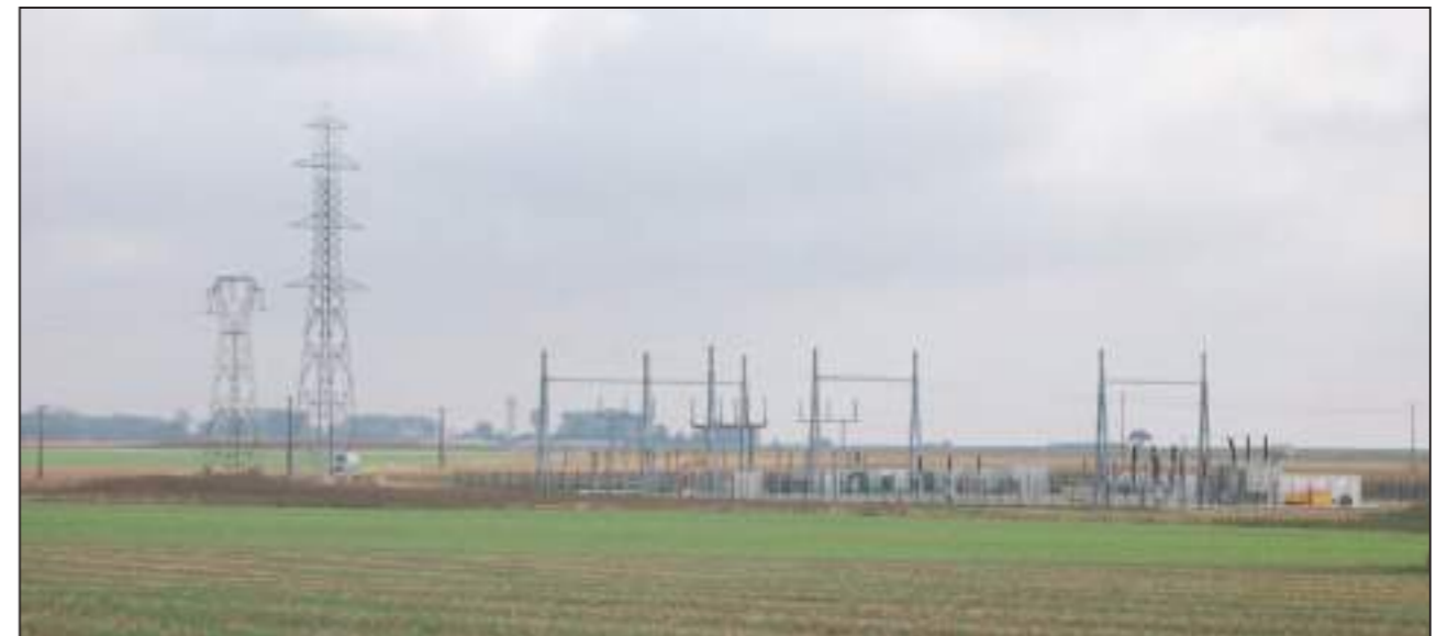
Figure 11 : Poste de raccordement du parc éolien « Le Nouvion » à la ligne THT à 225000 volts
