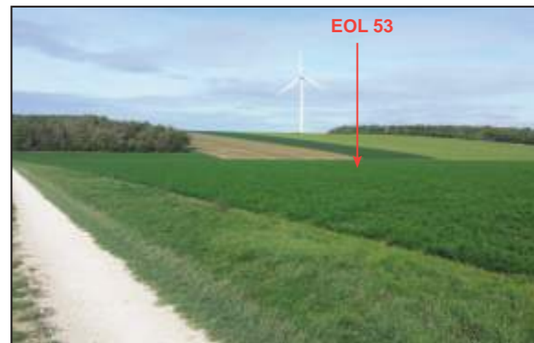
Figure 28 : Site d'implantation de l'éolienne EOL 53
