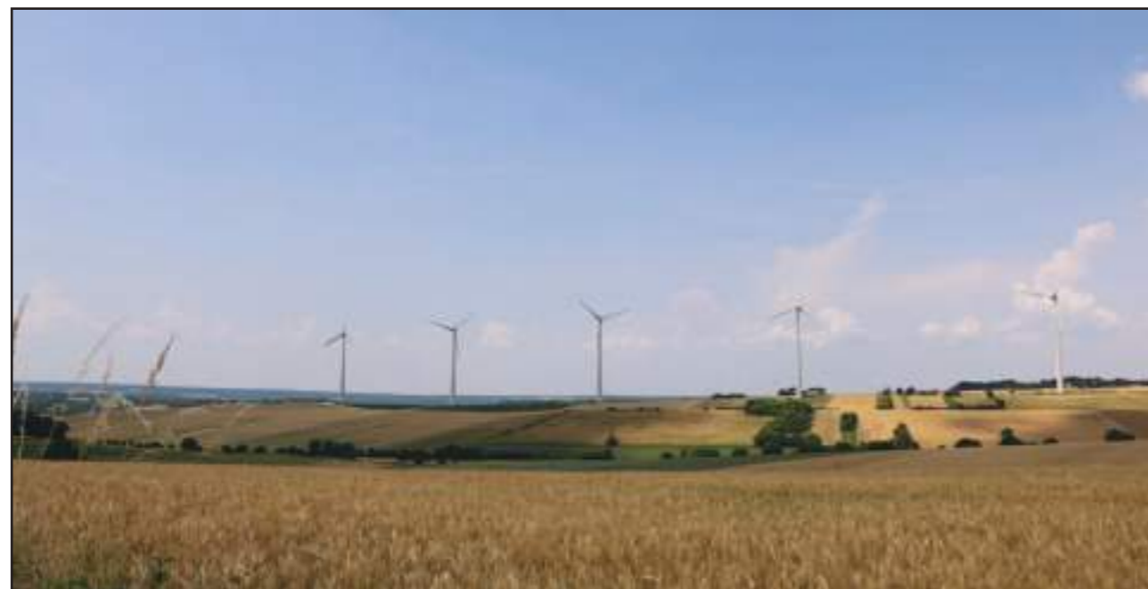
Figure 7 : Parc éolien de Bouhy (11,5 MW), construit en 2017
