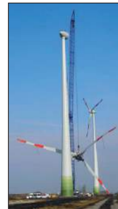
Figure 52 : Montage du rotor
