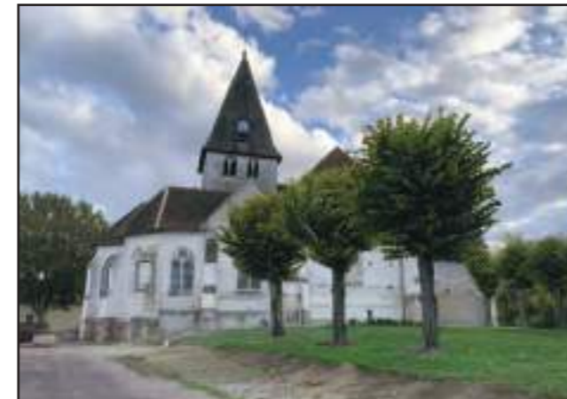
Figure 275 : Église de Chapelle-Vallon
